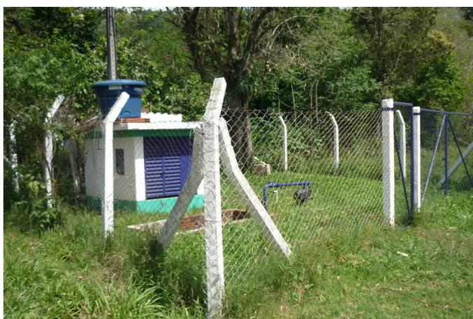
Figura 4.2 : Poço de captação da CASAN com casa de química
