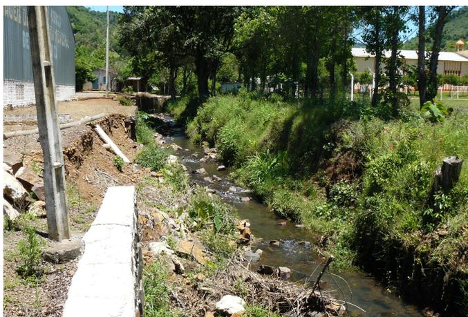
Figura 7.8: córrego retificado e erosão das margens.
