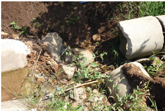
Figura 7.7: Falta de caixa de passagem na galeria.
