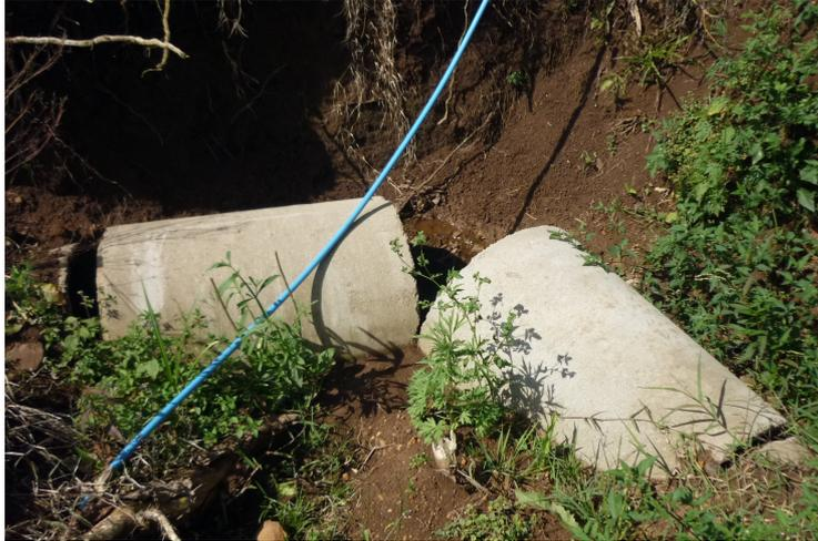
Figura 7.9: falta de caixa de passagem.
