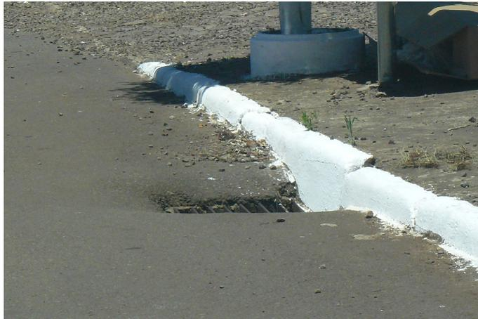
Figura 7.5: boca de lobo com grelha concretada.
