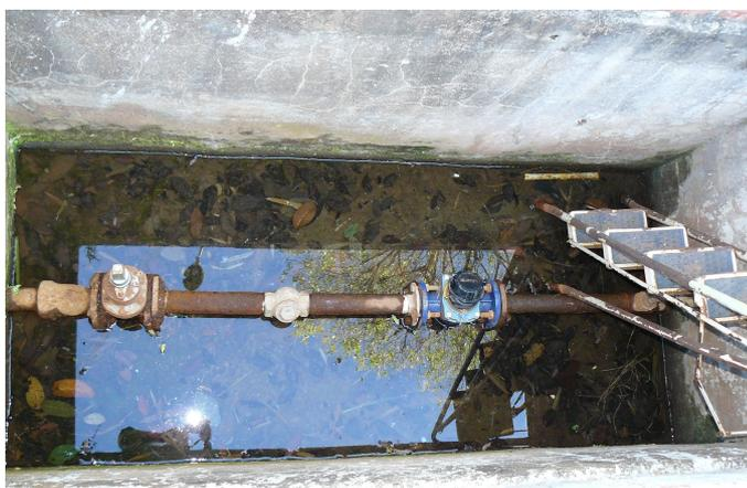
Figura 4.7: Macromedição na saída do reservatório
