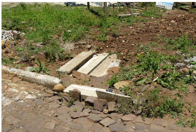
Figura 7.6: boca de lobo necessitando de manutenção.
