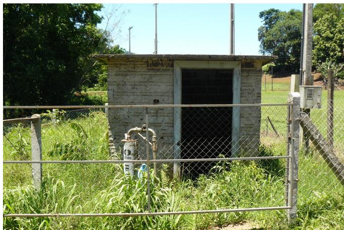
Figura 4.22: Poço de captação coletivo
